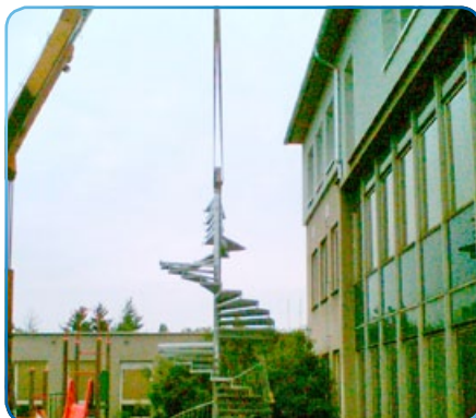
Montáž požárního schodiště
