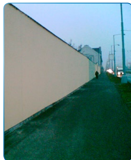
Po prořezu spár a po nátěru
