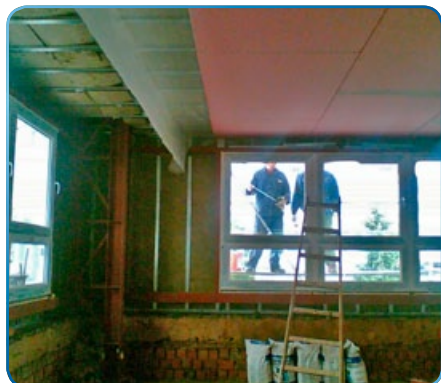
Při provádění nástavby
