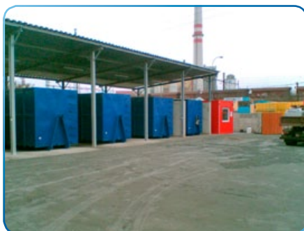
Přístřešek s kontejnery
