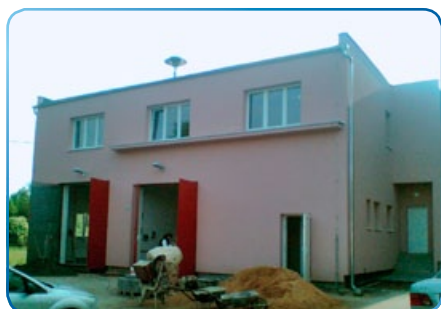
Rekonstrukce před dokončením...
